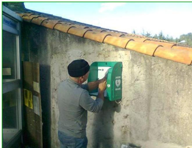
*L'installation du défibrillateur sur la place, dans un coffret chauffé en hiver, et relié à une alarme qui se déclenche en cas d'ouverture, ainsi qu'à un système de contrôle de bon fonctionnement.*
